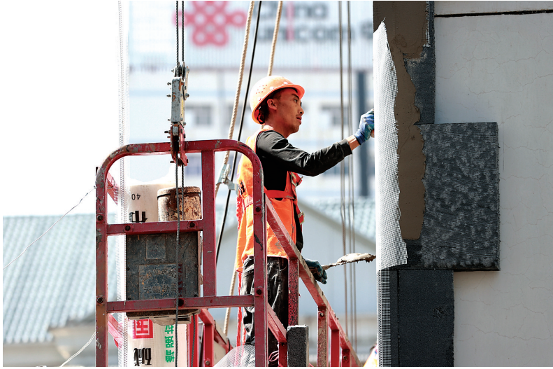
图为老旧小区外立面保温施工
